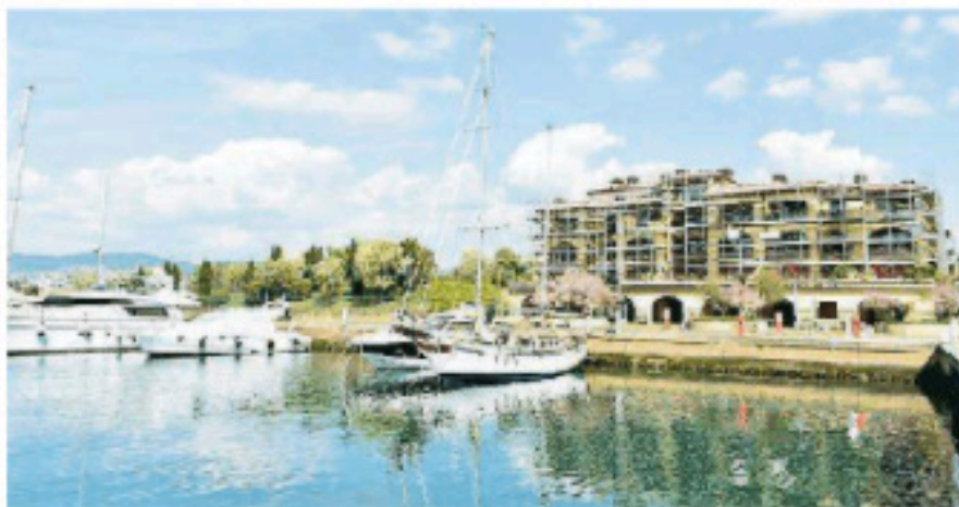
Il cantiere di Borgo San Rocco
